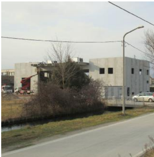
L'impianto in costruzione in via Nodari
